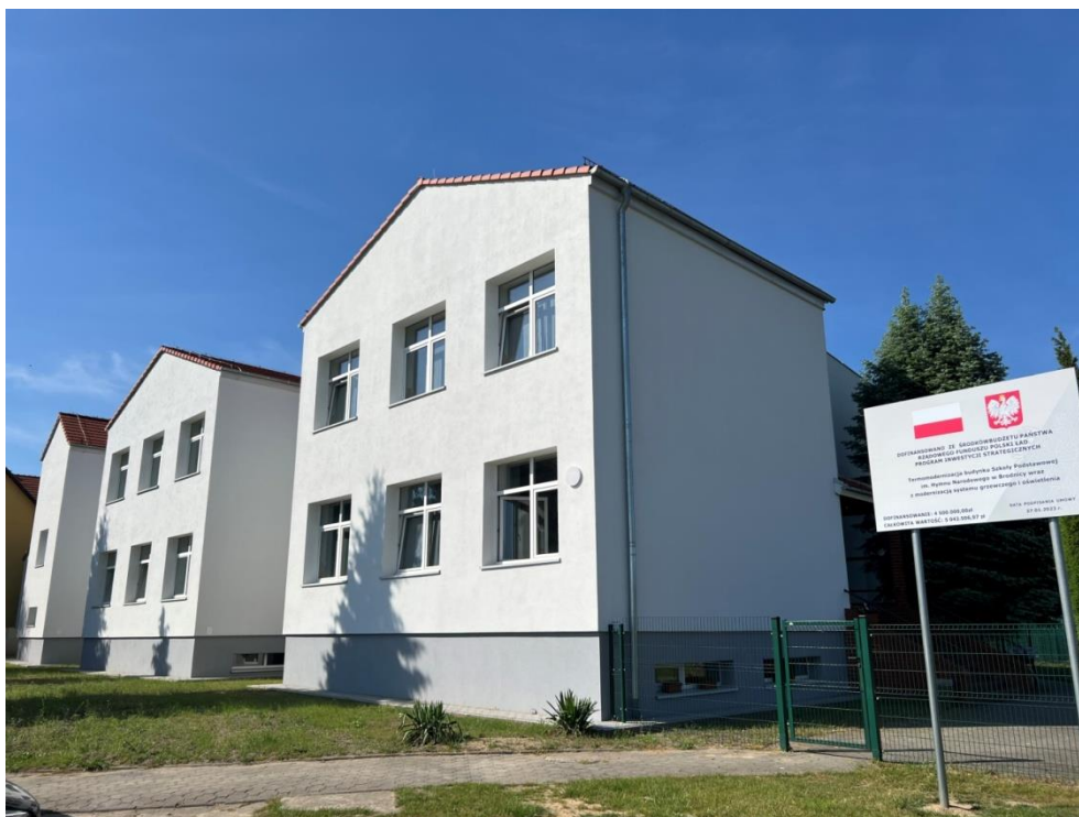
Budynek Szkoły Podstawowej w Brodnicy po zakończeniu realizacji zadania: „Termomodernizacja budynku Szkoły Podstawowej im. Hymnu Narodowego w Brodnicy wraz z modernizacją systemu grzewczego i oświetlenia”.
