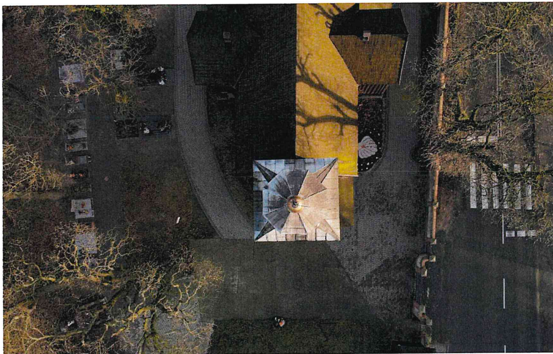
Fot.6. Wieża kościoła w Żabnie – widok z lotu ptaka, źródło: własne (styczeń 2023)
