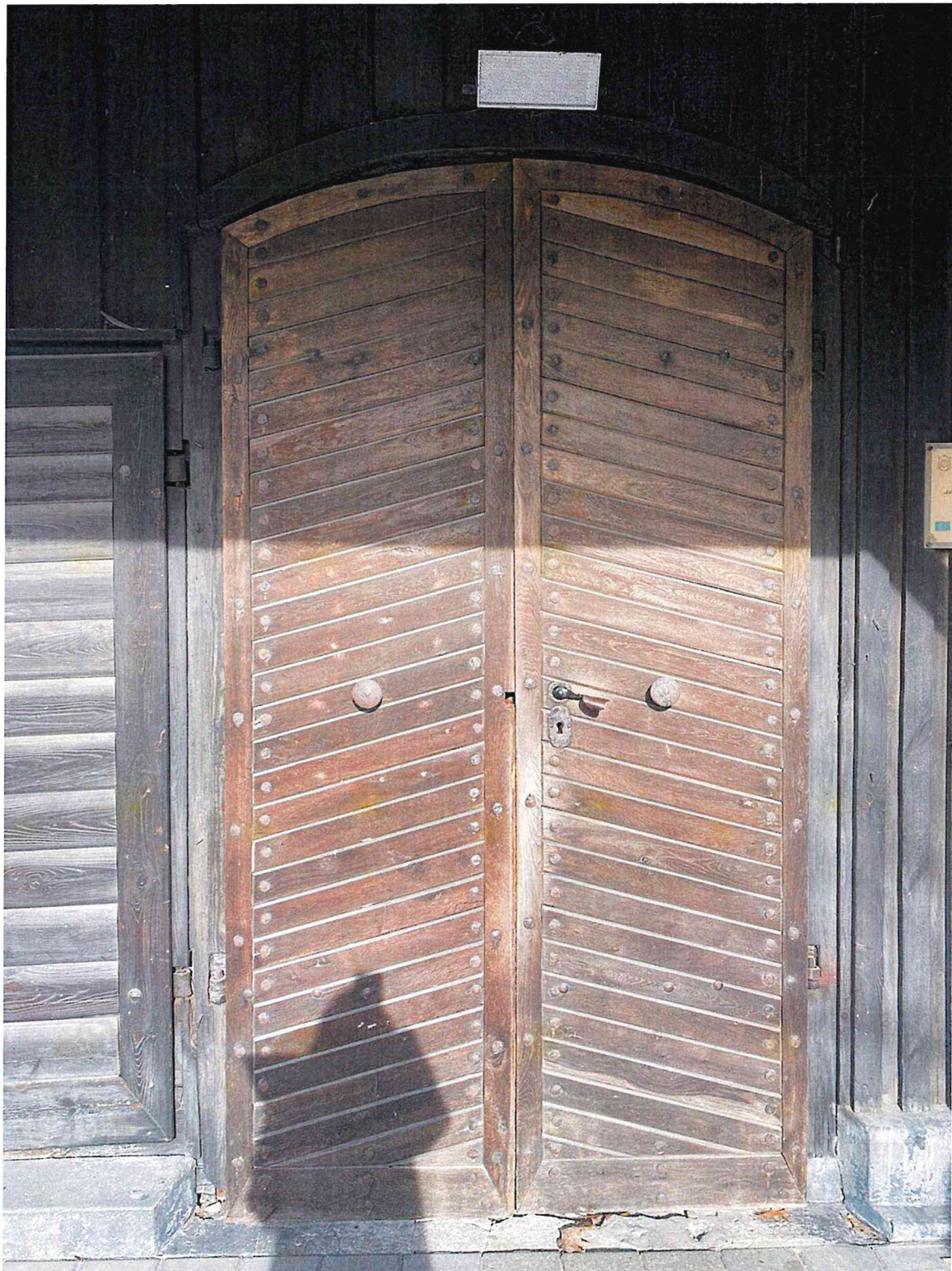
Fot. 13. Wieża kościoła w Żabnie – widok szczegółowy, źródło: własne (styczeń 2023)
