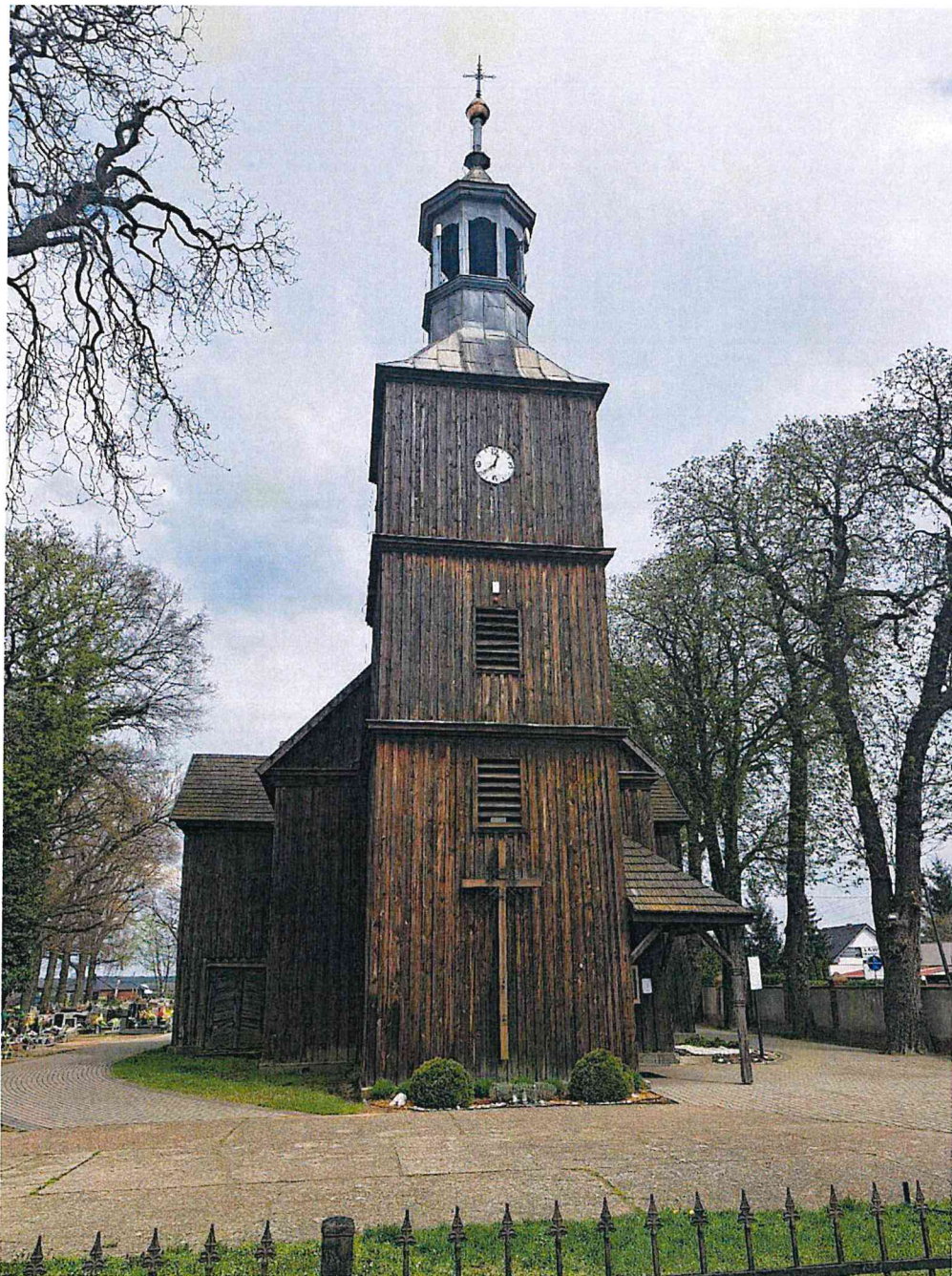
Fot 1. Widok kościoła od strony południowej.
