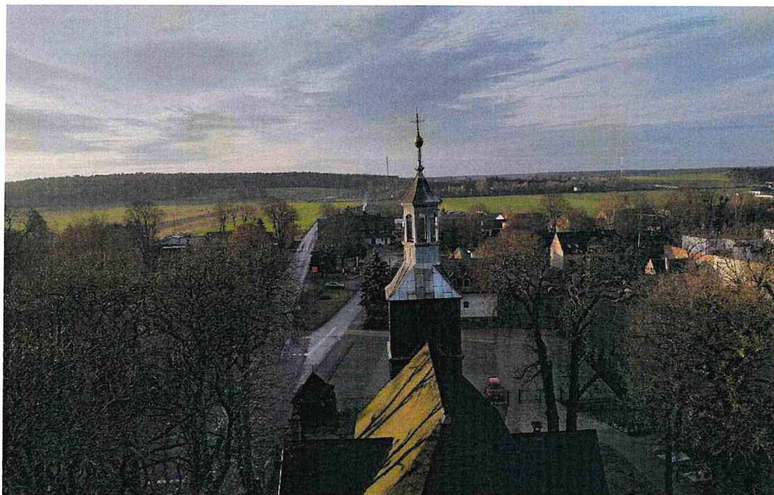
Fot.4. Wieża kościoła w Żabnie – widok z lotu ptaka, źródło: własne (styczeń 2023)
