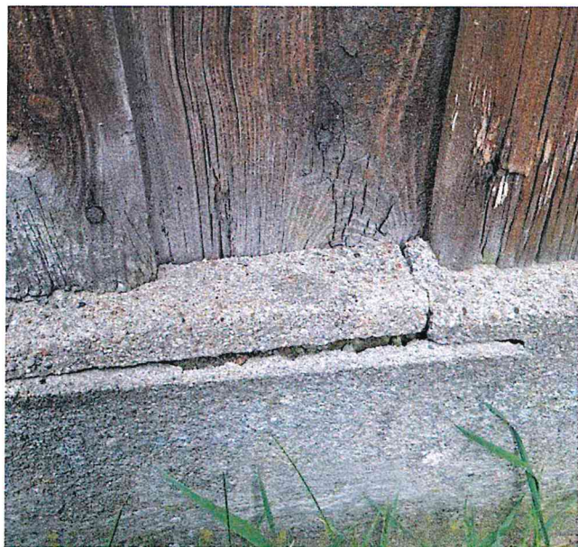
Fot 6 i 7. Stan zachowania cementowego pasa w obrębie podwaliny.
