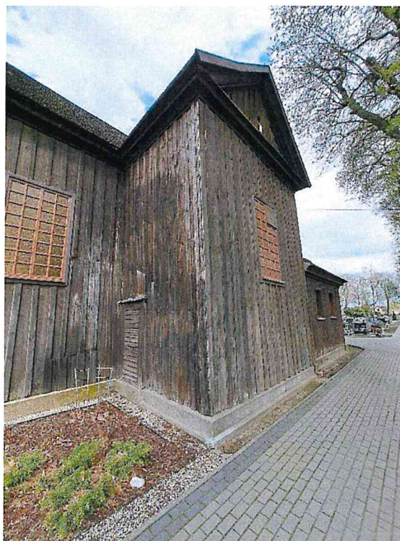
Fot 8 i 9. Ogólny widok ścian od strony prezbiterium. Widoczna wyraźna zmiana kolorystyki spowodowana czynnikami atmosferycznymi. W tej części kościoła stolarka okienna została wymieniona na nową.
