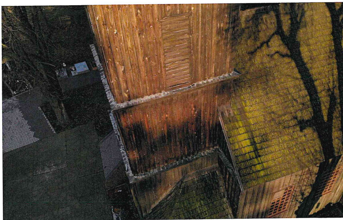
Fot.9. Wieża kościoła w Żabnie – widok z lotu ptaka, źródło: własne (styczeń 2023)
