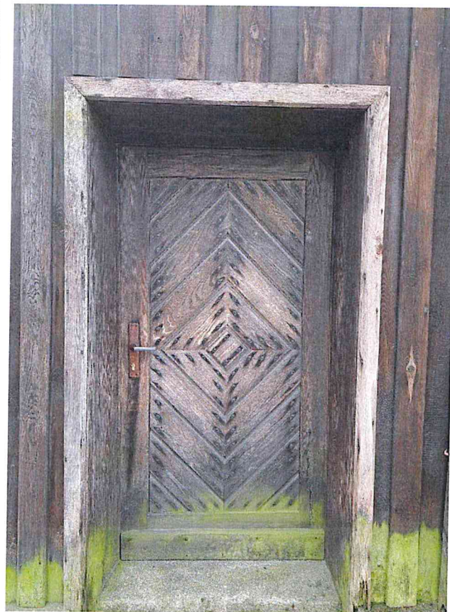
Fot 4 i 5. Stan zachowania stolarki drzwiowej w obrębie wejść do zakrystii oraz transeptu. Widoczna znaczna degradacja biologiczna oraz zniszczenia w obrębie konstrukcji drzwi.
