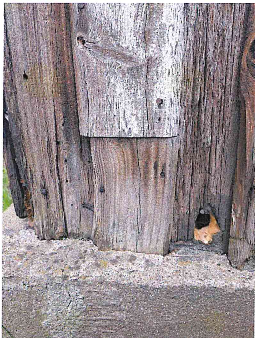
Fot. 11 i 12 Widoczne uzupełnienia w obrębie drewnianego obicia elewacji. Skorodowane gwoździe należy w tym przypadku usunąć.
