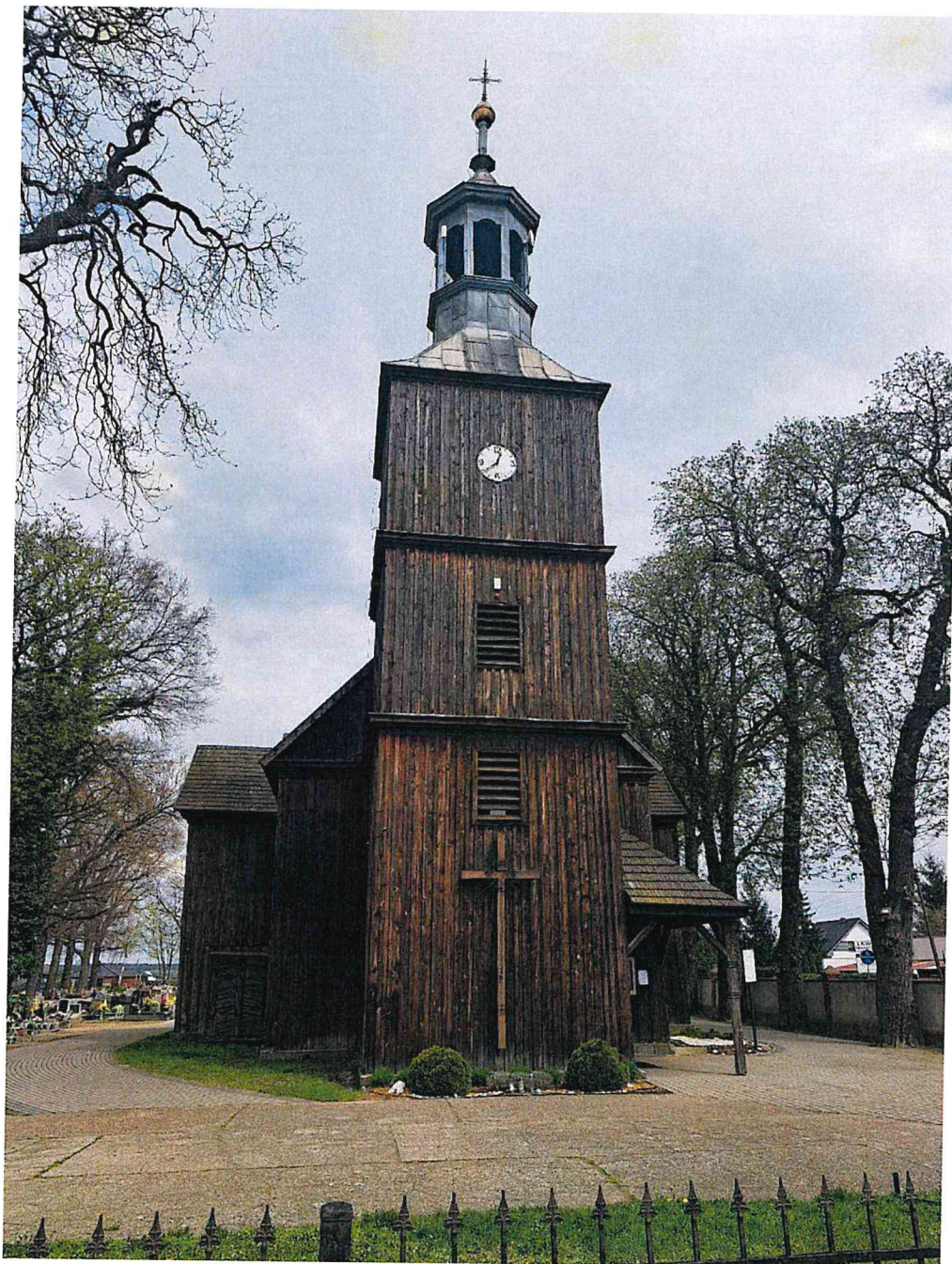
Fot 1. Widok kościoła od strony południowej.
