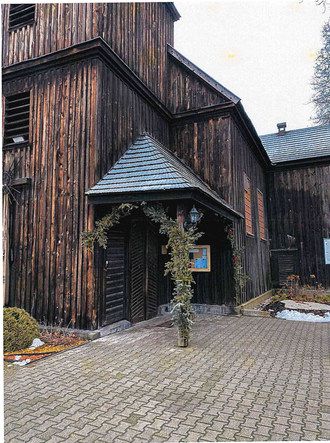
Fot.11. Wieża kościoła w Żabnie – widok szczegółowy, źródło: własne (styczeń 2023)
